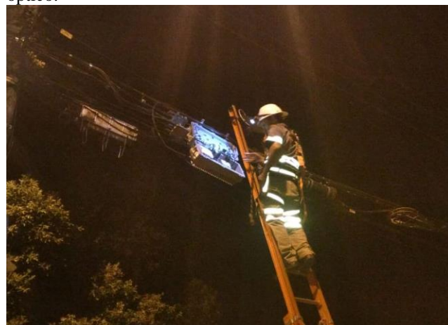
Figura 9: Técnico efetuando validação junto ao transceptor óptico.
